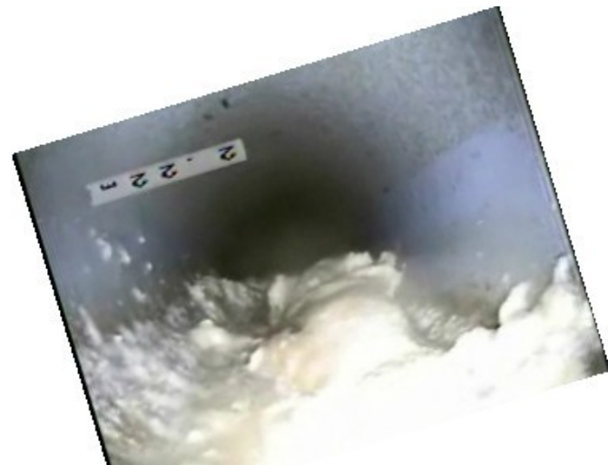
小便器横引き配管内部(竣工後32ヶ月経過、尿石分解装置付き)
