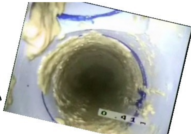
小便器横引き配管内部(竣工後32ヶ月経過、尿石分解装置付き)
