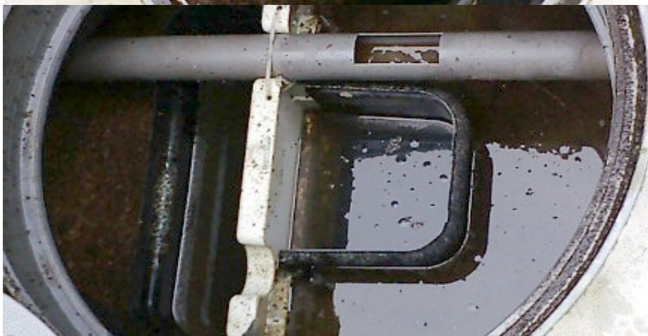
着手前 (引き抜き予定2ヶ月前)
