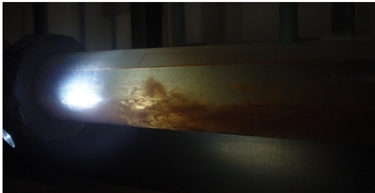
排水管内部の状況
